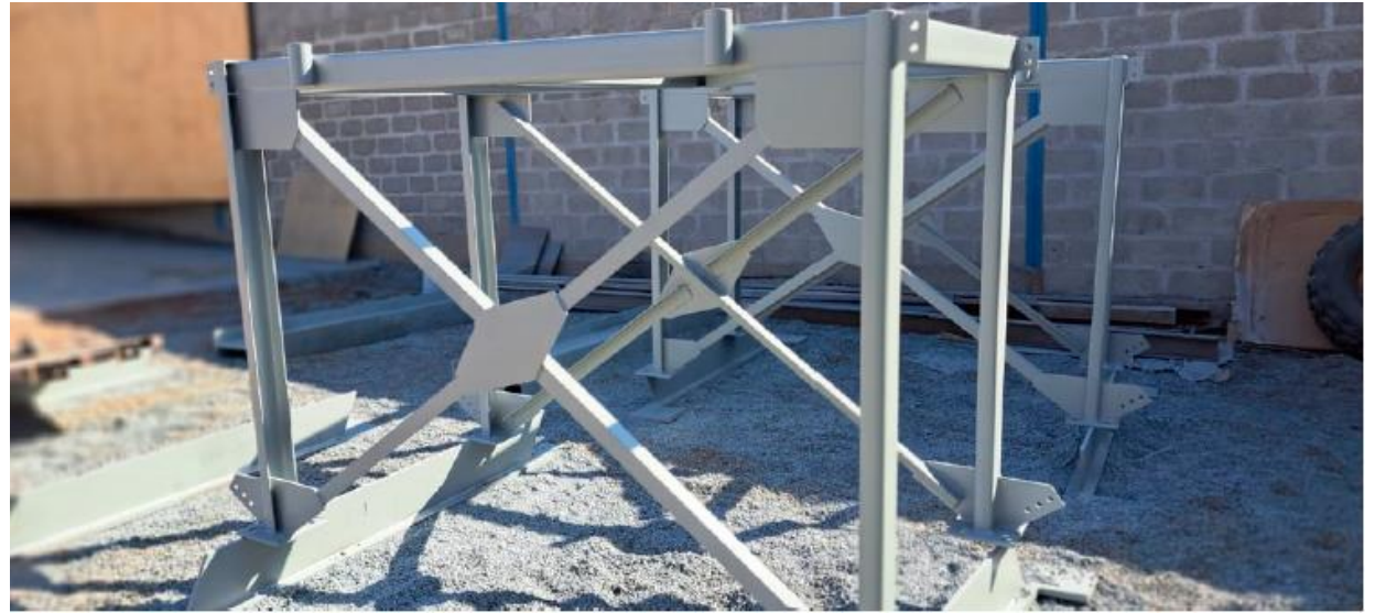
PINTADO DE ESTRUCTURAS
